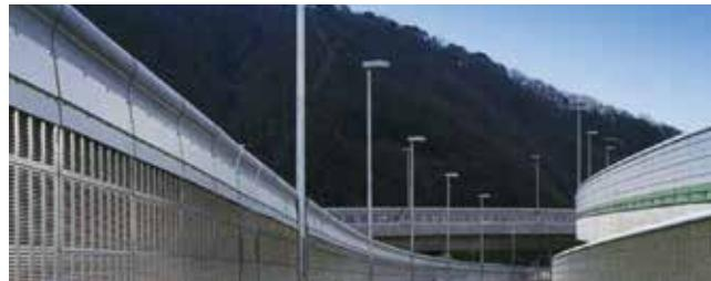
それぞれの仕向け先仕様に基づいた両面支柱隠蔽パネルです。正面と背面の支柱を隠蔽することでスッキリとした外観を実現。景観に配慮した都市型遮音壁です。
