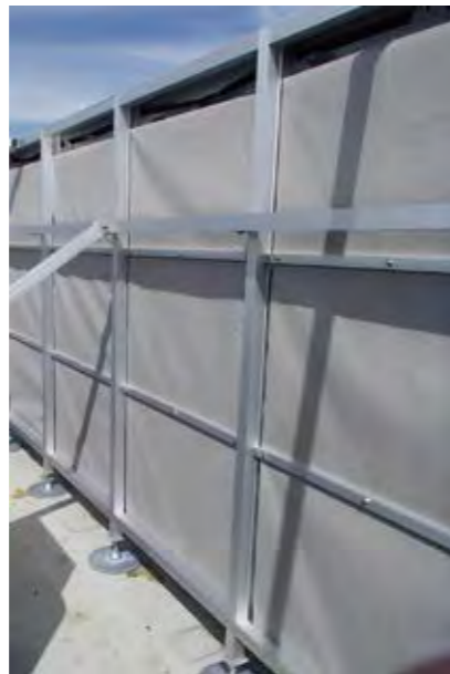
▲施工例(アルミフレーム固定)
