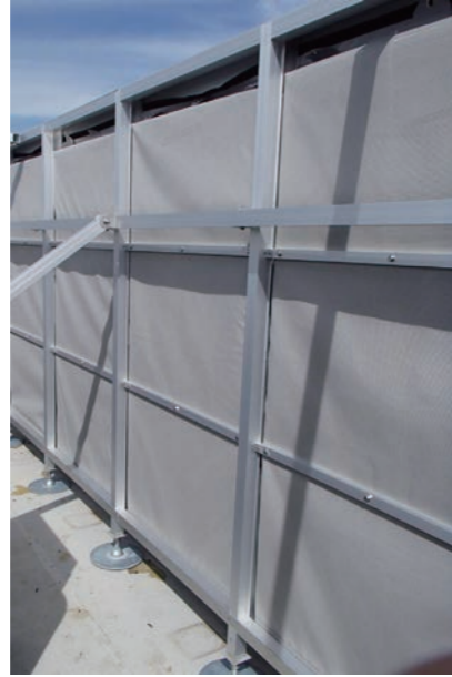
▲施工例(アルミフレーム固定)
